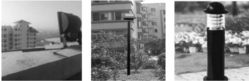
小区分布楼顶射灯天线 小区分布底层射灯天线 小区分布草坪灯天线
