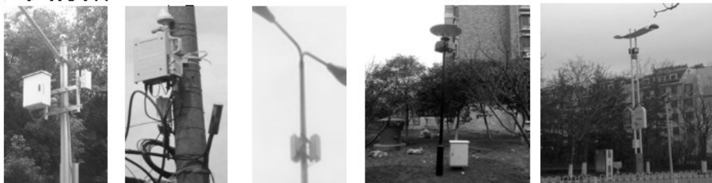
监控杆安装 电力杆安装 路灯杆安装 居民区灯杆安装 路牌杆安装
